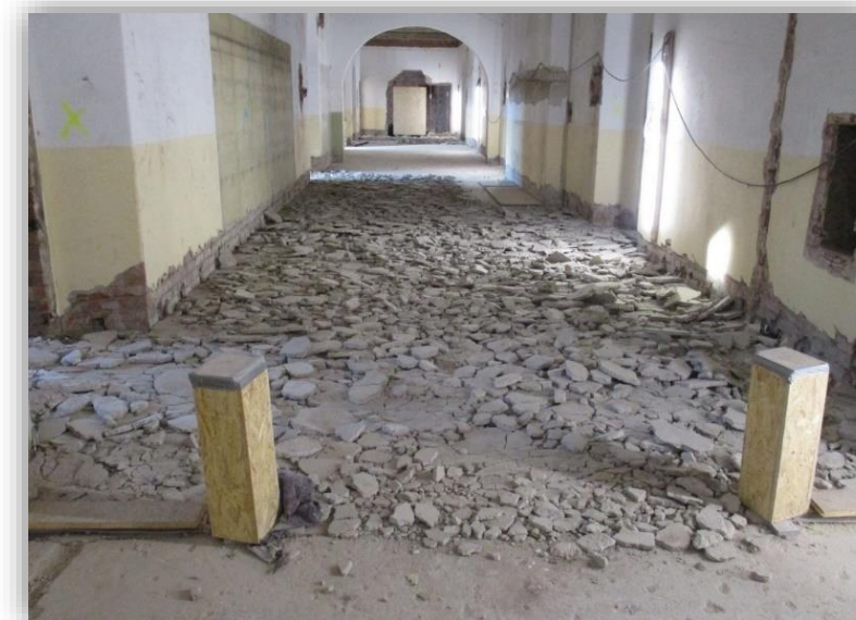
Bauhauf GmbH / St. Gobain-Weber Erlwein Berufsschule Dresden Instandsetzung + Verstärkung historischer Betondecken
