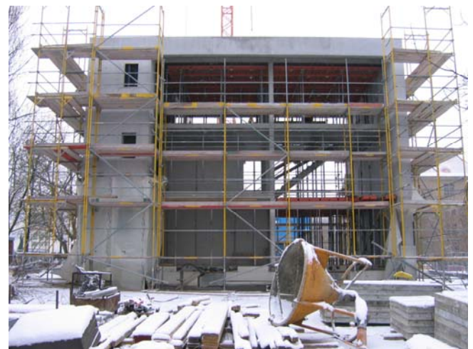
Bild 19. Nordseite des Hauses im Bau
