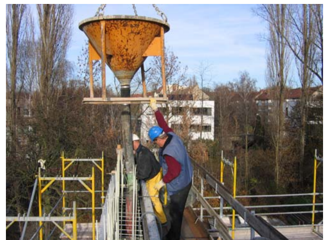
Bild 12. Ausbreitmaß und Einbringen mit Kübel
