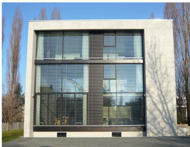
Bild 2. Fertiges Haus mit Infralichtbetonaußenwänden
