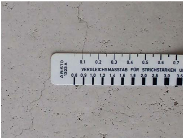
Bild 13. größte Rissbreite nach einem Jahr Fig. 13. maximum crack width after one year
