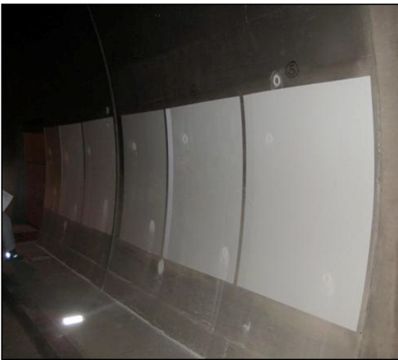
Abb. 2: Musterflächen im Grenztunnel Füssen
