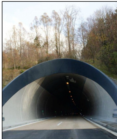
Abb. 1: Kohlbergtunnels A 96 Memmingen - Mindelheim
