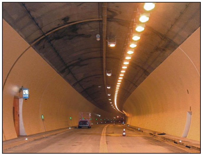
Abb. 3: Grenztunnel Füssen nach Instandsetzung
