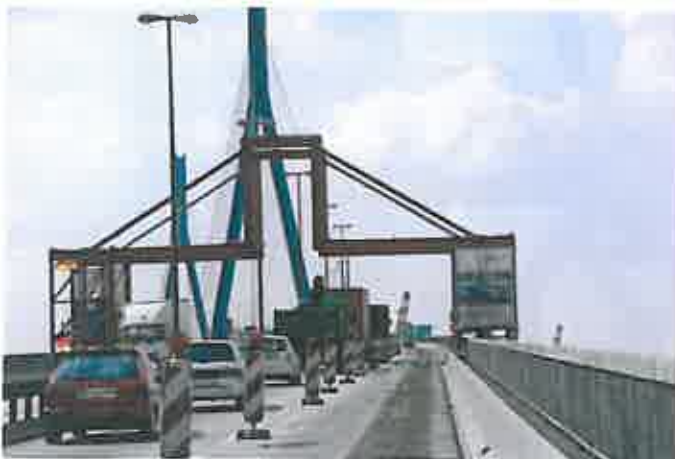
Abb. 4: Für die Sanierungsarbeiten wurde ein spezielles Fahrgerüst entwickelt
