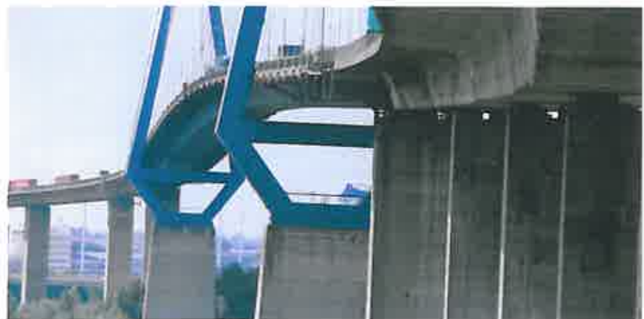
Abb. 12: Die sanierte Brückenunterseite
