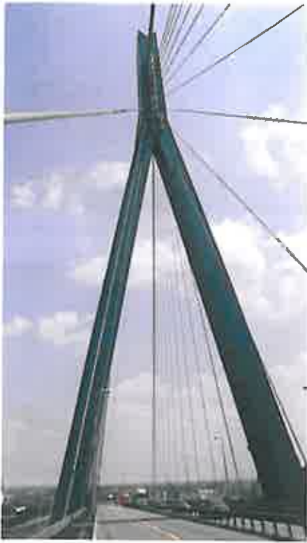
Abb. 2: Mit den weithin sichtbaren 135 m hohen Pylonen prägt die 3,6 km lange Hamburger Köhlbrandbrücke die Kulisse des Hamburger Hafens
