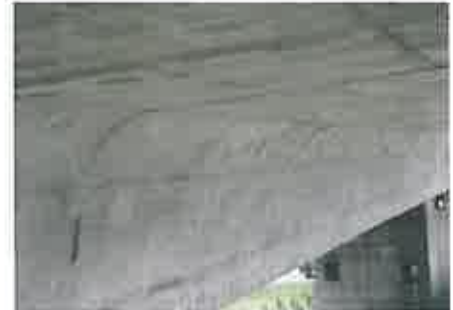
Abb. 10: Wie ein flickenteppich sieht die Brücke von unten aus, wenn die Instandsetzungsarbeiten abgeschlossen sind
