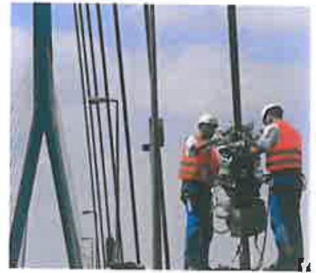
Abb. 3: Mit einer Spezialmaschine (Einwickeltechnik) wird auch der Korrosionsschutz der 88 Stahlseile, die die Brückenkonstruktion tragen, erneuert
