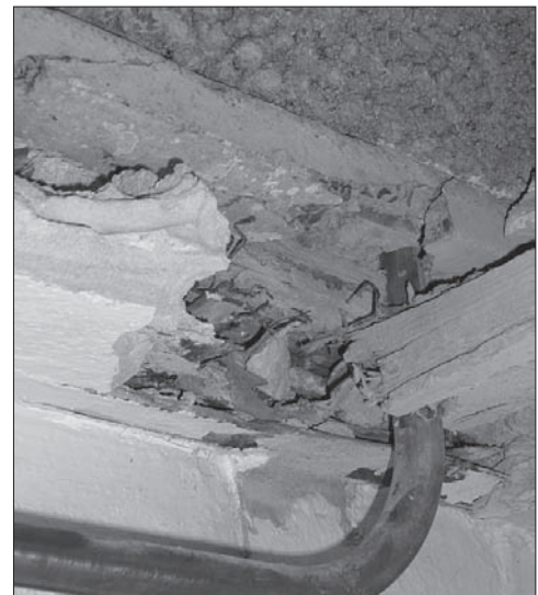
Spannbetonrippe muss Leitung weichen
