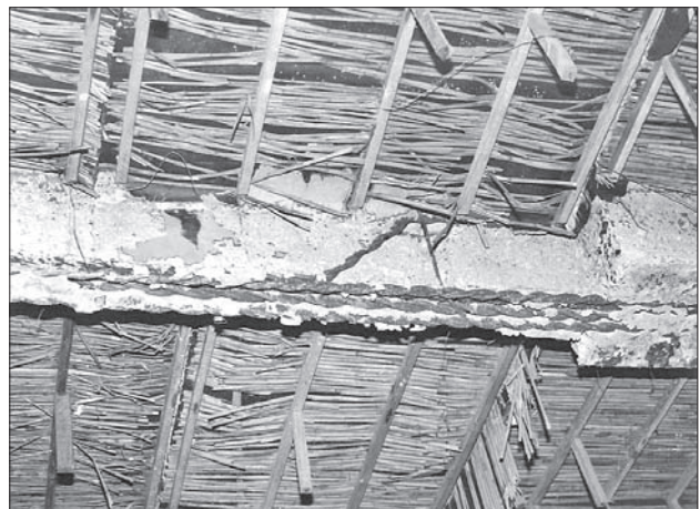
Freie Rippenbewehrung in einer Kaserne nach Wegnahme der Schalung aus Röhricht
