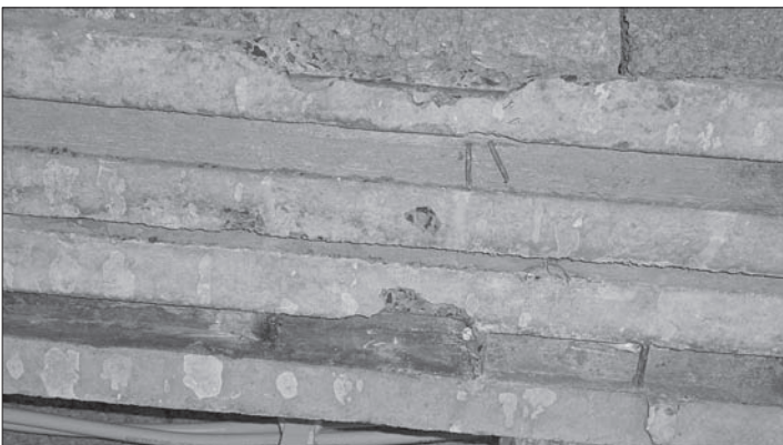
Untersicht einer Doppelrippe
