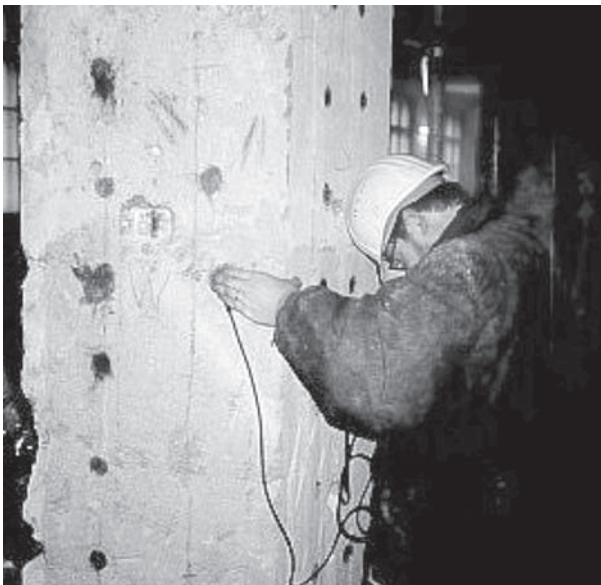
Bild 1: Ultraschall-Messung (Transmissionsverfahren) zur Detektion von Verdichtungsmängeln im Inneren von Betonstützen
