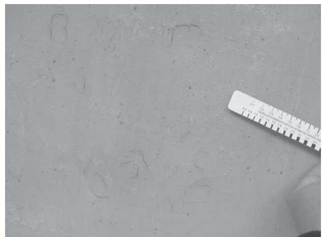
Bild 5: Reprofilierung mit flexibler Dichtungsschlämme (OS 5)
