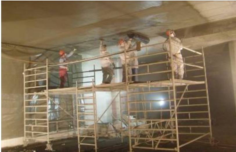
Bild 5 Alle Arbeitsschritte in einem Blick
