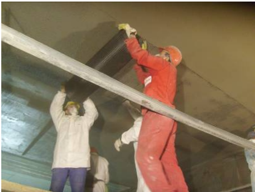
Bild 4 Einbau des textilen Geleges
