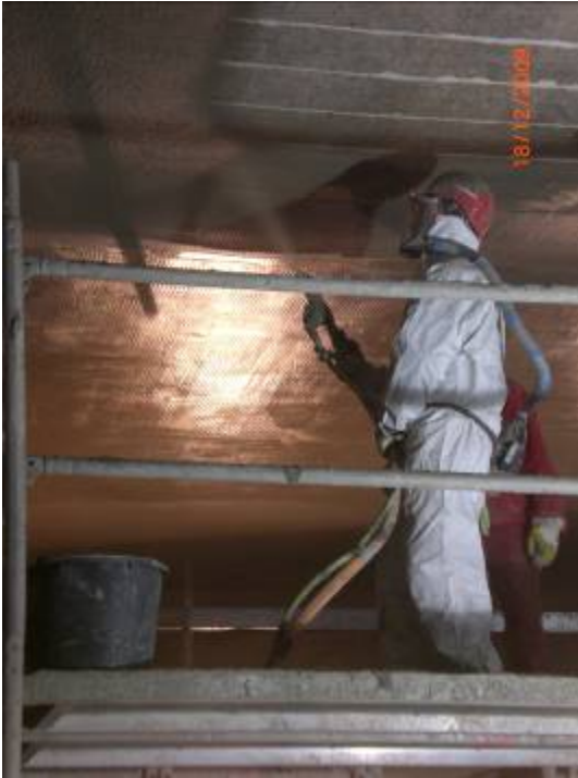
Bild 3 Aufspritzen des Feinbetons
