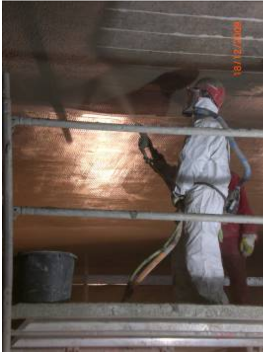
Bild 3 Aufspritzen des Feinbetons
