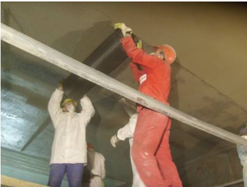
Bild 4 Einbau des textilen Geleges
