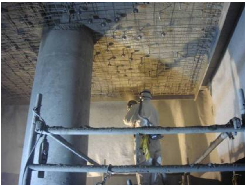
Bild 6 Erhöhung der Plattendicke im Durchstanzbereich mit bewehrtem Spritzbeton
