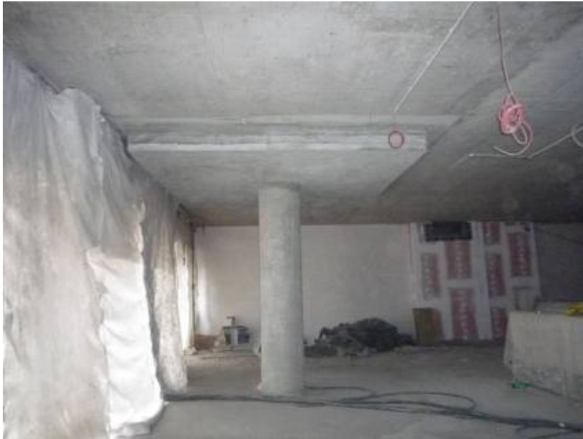
Bild 7 Verstärkter Durchstanzbereich
