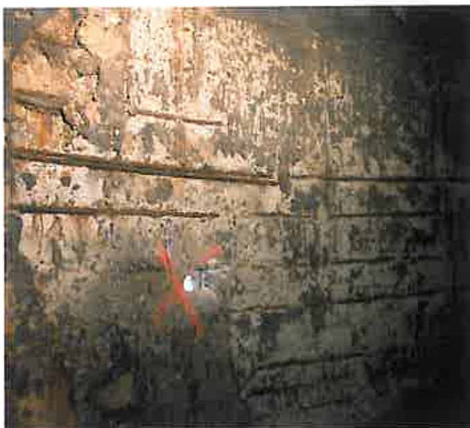
Die Schornsteintrommel vor ...
