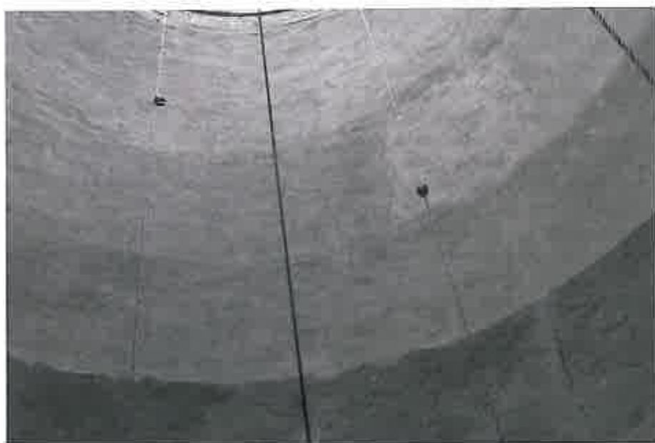
... und nach der Betoninstandsetzung. Fotos: Ingenieurbüro H.-J. Schwarzenstein
