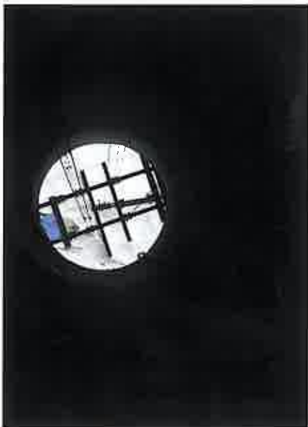
An acht Sellen hängt sie im Schornsteinschacht, weitere Sellen dienen dem Materialtransport.
