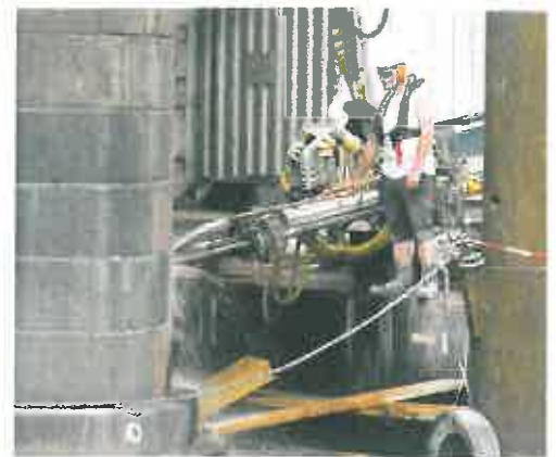
Injektionsbohrungen an der Pfeilervortage
