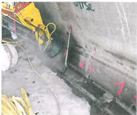
Probebohren mit 1m-Loch-Hammer
