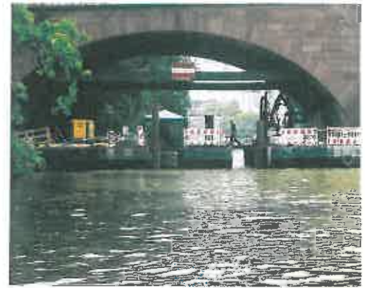
Die Arbeitspontons werden vorbereitet und positioniert.
