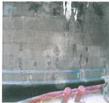
Etwa 2.200 Bohrungen für rund 1,1 Millionen Liter Bindemittel wurden durchgeführt. Hier wieder verschlossene Bohransatzpunkte.
