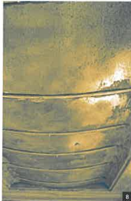
Abb. 8: Beim Spritzbetonauftrag wurde zunächst die Bewehrung eingespritzt.
