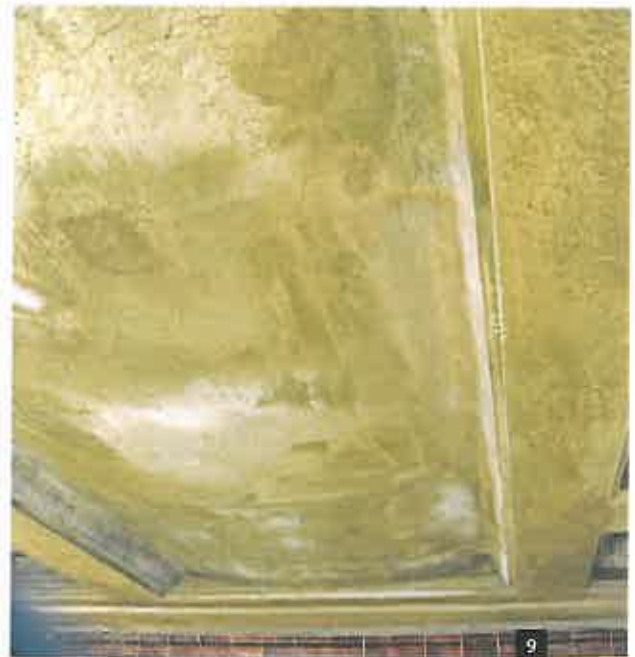
Abb. 9: Damit die Höhe der Deckenkonstruktion die des alten Bestands beibehielt, wurde die Schalung entsprechend dem zuvor genommenen genauen Aufmaß angebracht. Die Deckchicht wurde dann bis zur Höhe der Schalung mit einem Spritzmörtel der Güteklasse C 25/30 in vier Millimeter Körnung ausgeführt.
