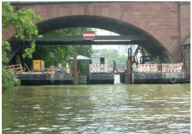
Vorbereitung und Positionierung der Arbeitspontons
