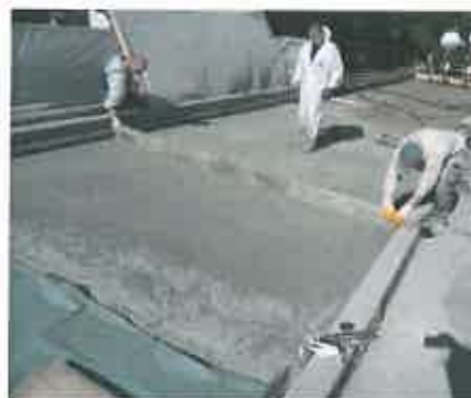
Einbau und Abziehen des Spritzbeton-Planums
