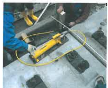
Ausrichten der Gleisbett-Fertigteile
