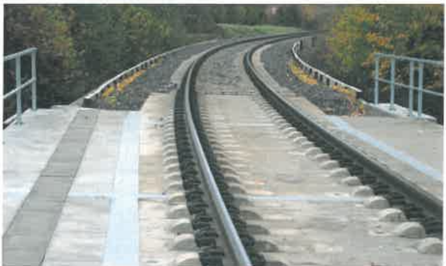
Fertiggestellte Bahnstrecke – Blick nach Usingen
