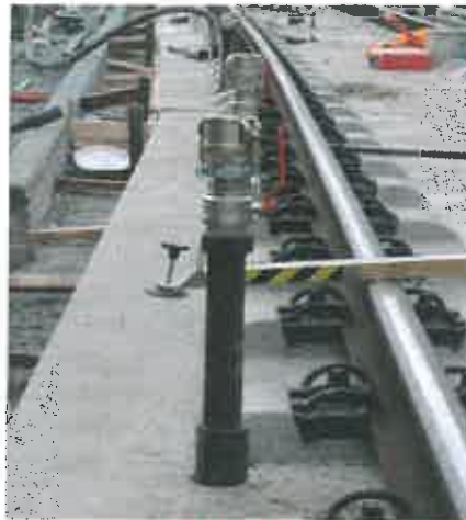
Unterpressarbeiten über das Einfüllstutzen-Kupplungsstück
