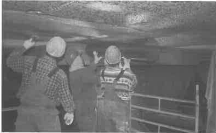
Bild 3: Verstärkung einer Geschossdecke
