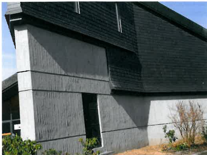
Bild 2 Nach der Instandsetzung wurde der untere Fassadenbereich als Sichtbeton ausgearbeitet, während der obere Bereich nach Abstimmung zwischen dem Bauherrn, der evangelischen Kirchengemeinde Sarnau sowie der beteiligten Architekten Himmelmann und Schneider-Lange eine Vorsatzschale aus Schiefer erhielt. Gut zu sehen die Scheinfugen, die die Oberfläche strukturieren.
