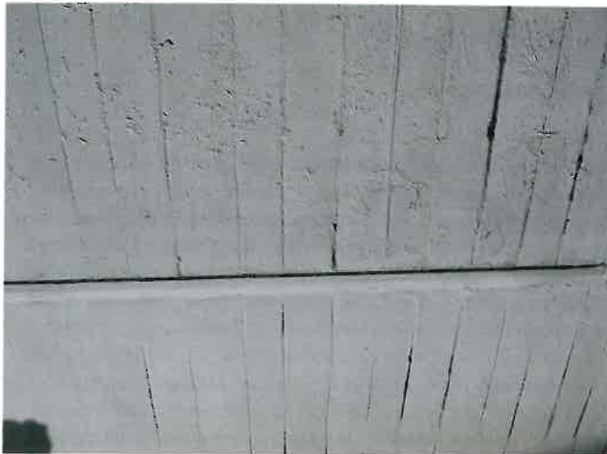
Bild 4 u. 5 Neue und alte Scheinfuge.
