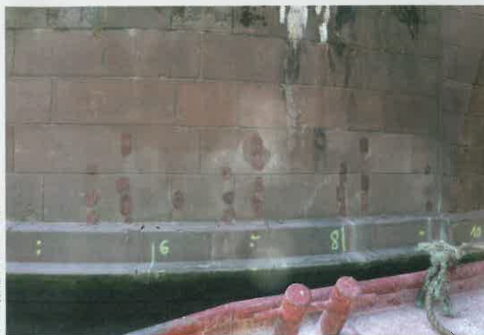
Die wieder verschlossenen Bohransatzpunkte an einem Pfeiler der Alten Brücke in Frankfurt am Main.
