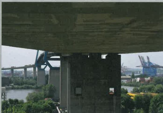
Wie ein Flickenteppich sieht die Köhlbrandbrücke von unten aus, wenn die Instandsetzungsarbeiten abgeschlossen sind.
