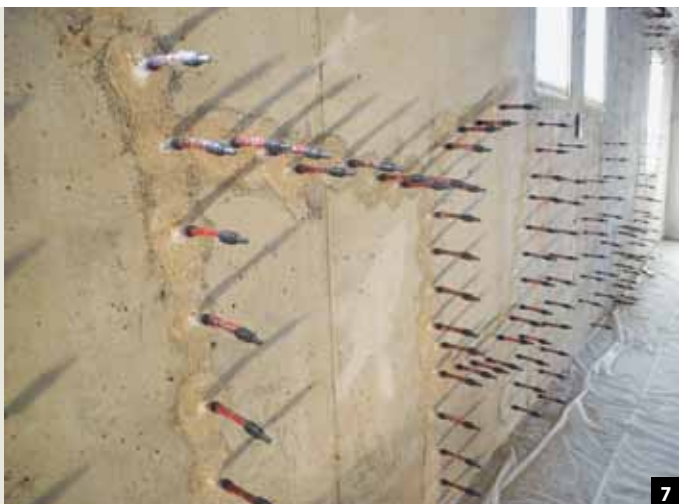
Abb. 7/8: Mit dem BICS-Injektionsverfahren (Ballon Injektion for Concrete Structures) wurden die Risse selbsttätig und mit einem geringem Druck von drei bar verpresst. Die Risse konnten dabei vollständig mit Polyurethan verfüllt werden.
