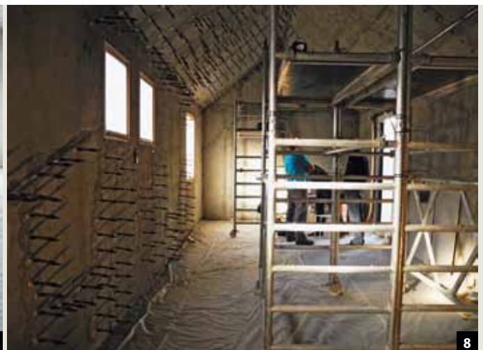
Abb. 7/8: Mit dem BICS-Injektionsverfahren (Ballon Injektion for Concrete Structures) wurden die Risse selbsttätig und mit einem geringem Druck von drei bar verpresst. Die Risse konnten dabei vollständig mit Polyurethan verfüllt werden.
