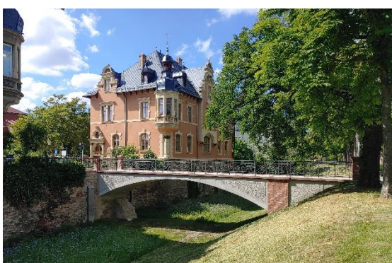
Abbildung 9: Brücke zur Thainburg in Naumburg (Saale) (Foto: CARBOCON GMBH)
