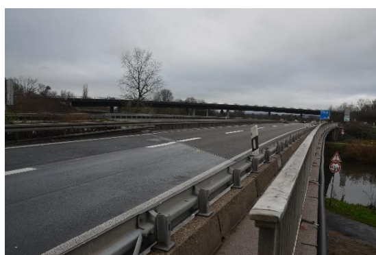
Abbildung 10: Autobahnbrücke A648 über die Nidda (Foto: CARBOCON GMBH)
