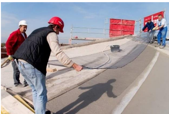
Abbildung 5: Schalenträgerwerk FH Schweinfurt (Foto: TU Dresden)
