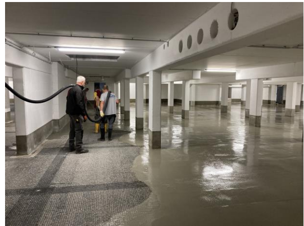
Bild 3: Großflächiger Auftrag im Stehen als Betonersatzmörtel in einer Tiefgarage (Quelle: F. Halm)
