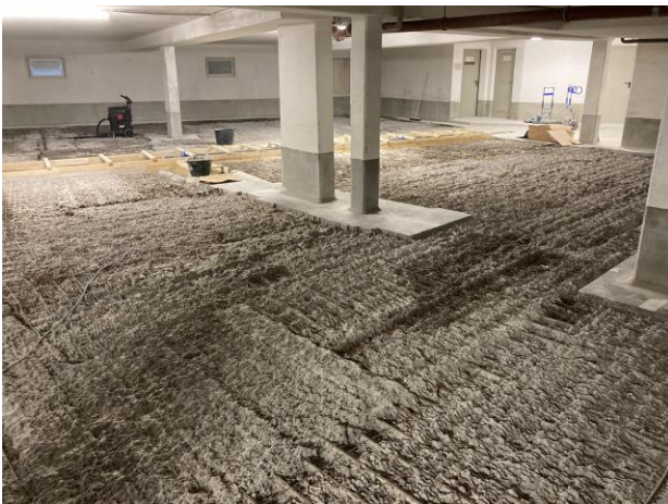
Bild 1: Tiefgaragensanierung (Quelle: F. Halm)
